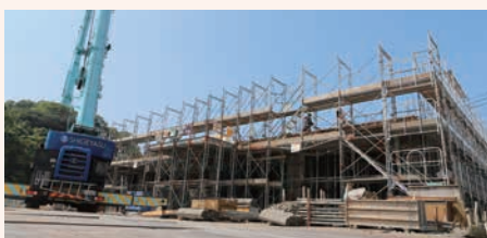
▲建設中の防災指令拠点施設
