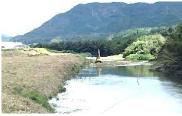
河道掘削が進む永代橋上流
