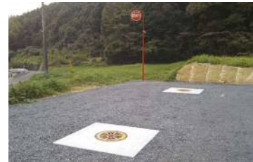
束荷地区の 防火水槽
