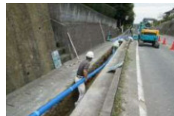
上水道の整備
